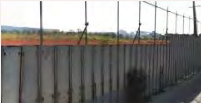
기존 비류대로 공장장 외벽
